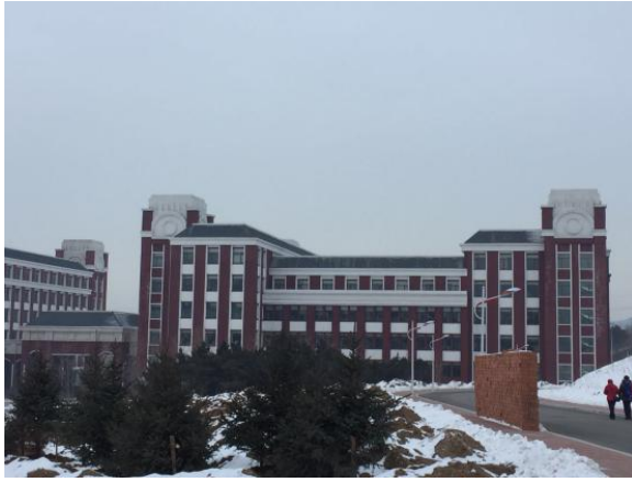
沈阳药科大学药学实验教学中心大楼
